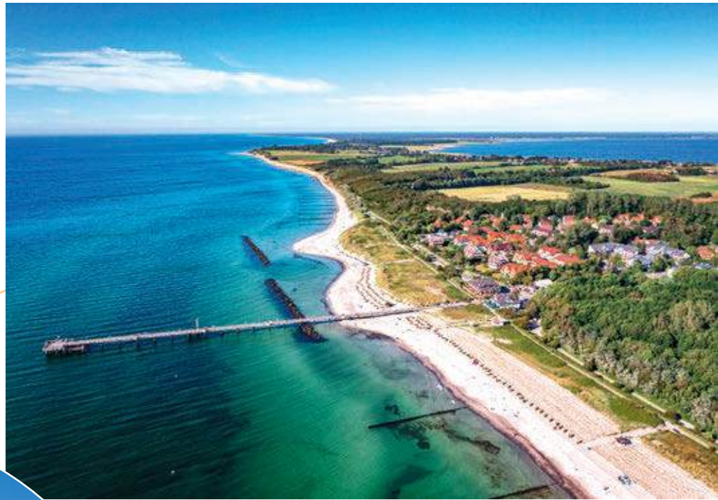
Oben: Die Seebrücke von Wustrow
